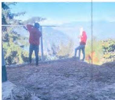
Foto 1: Sustitucion de maya y acabado de circulación y puerta de 1m 20cm
