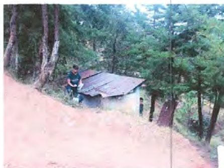
Foto 3: sustitucion de techa a baños
