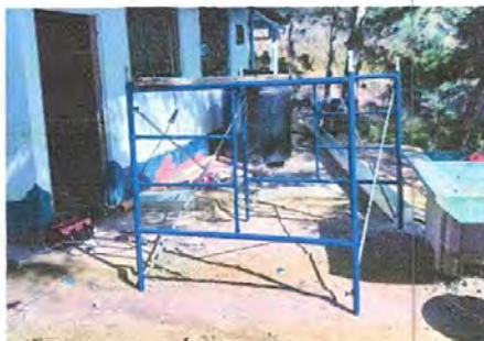
Foto 9: Reparacion de canales
