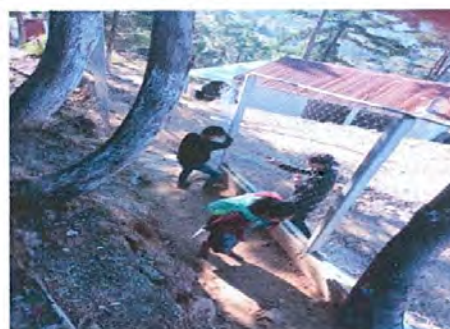
Foto 6: reparación de rampa y colocaación de piso de torta de cemento
